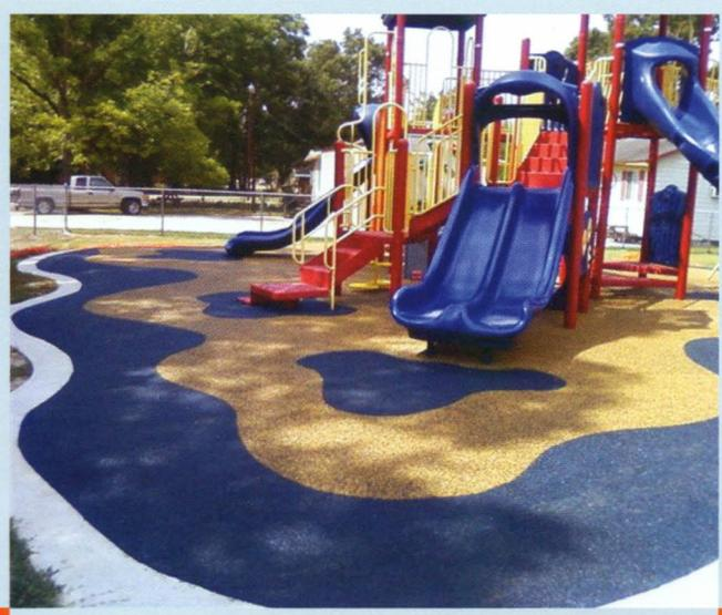
Il pavimento è realizzato in loco, ossia i materiali vengono miscelati in cantiere e l'applicazione degli stessi avviene mediante maestranze qualificate e macchinari specifici. Il manto è interamente realizzato con gomma sintetica, miscelata con resina poliuretanica elastica. Il prodotto ottenuto è altamente elastico, shock assorbente, confortevole e atossico.
